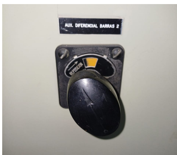
figura 5: Recorrido incompleto de relé 86B2 a la posición Operado
